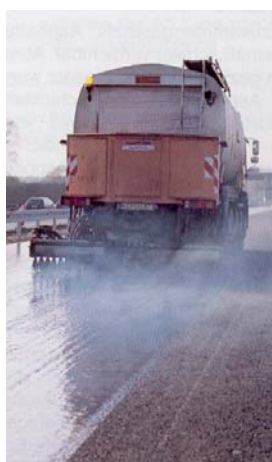
Postřík asfaltovou emulzí
