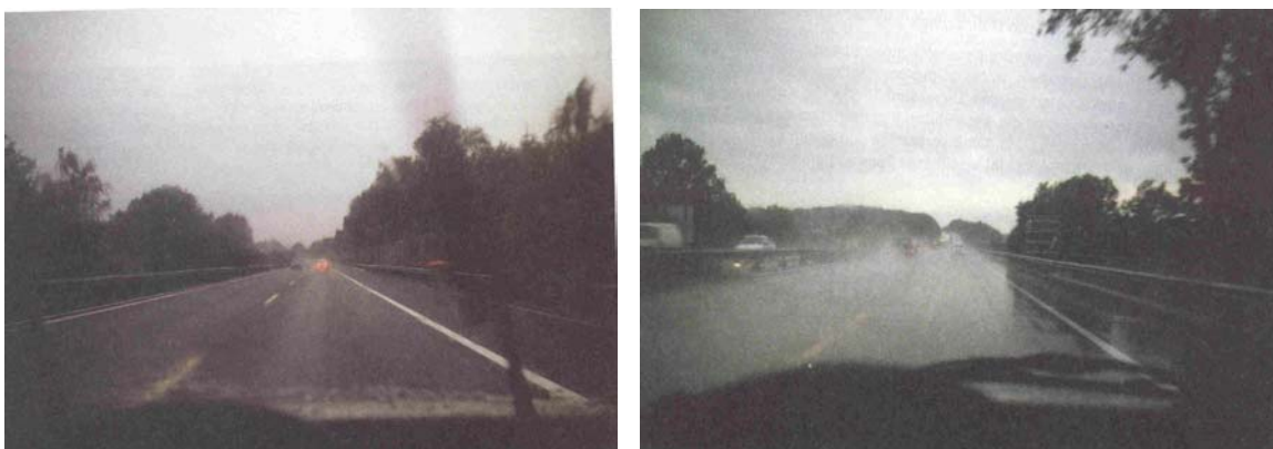
Obrázek 8 a 9: Příklad vozovky s drenážním asfaltovým kobercem (vlevo) a bez drenážního asfaltového koberce (vpravo).
